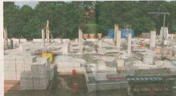
Die Baustelle: Hier sollen 22 neue Klassenräume entstehen.
