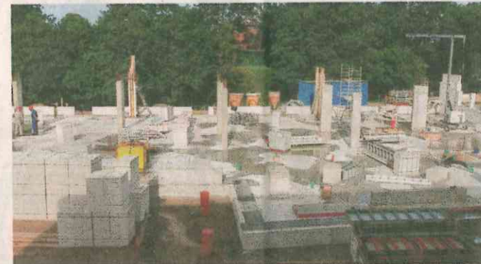
Die Baustelle: Hier sollen 22 neue Klassenräume entstehen.
