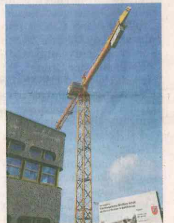
Der riesige Kran neben der Berufsschule prägt derzeit das Bild.
